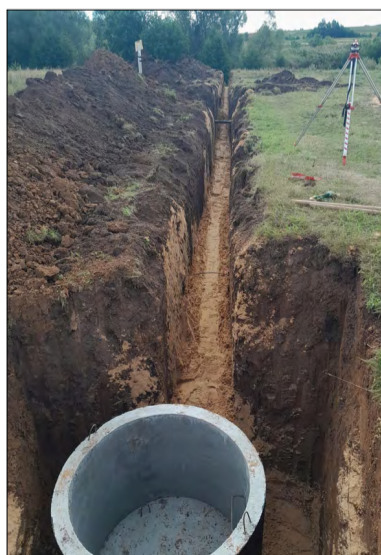
Муркашри Восточная урамри нумай хваттерлэ суртсем валли канализацион биологический блок системине тавассё.
